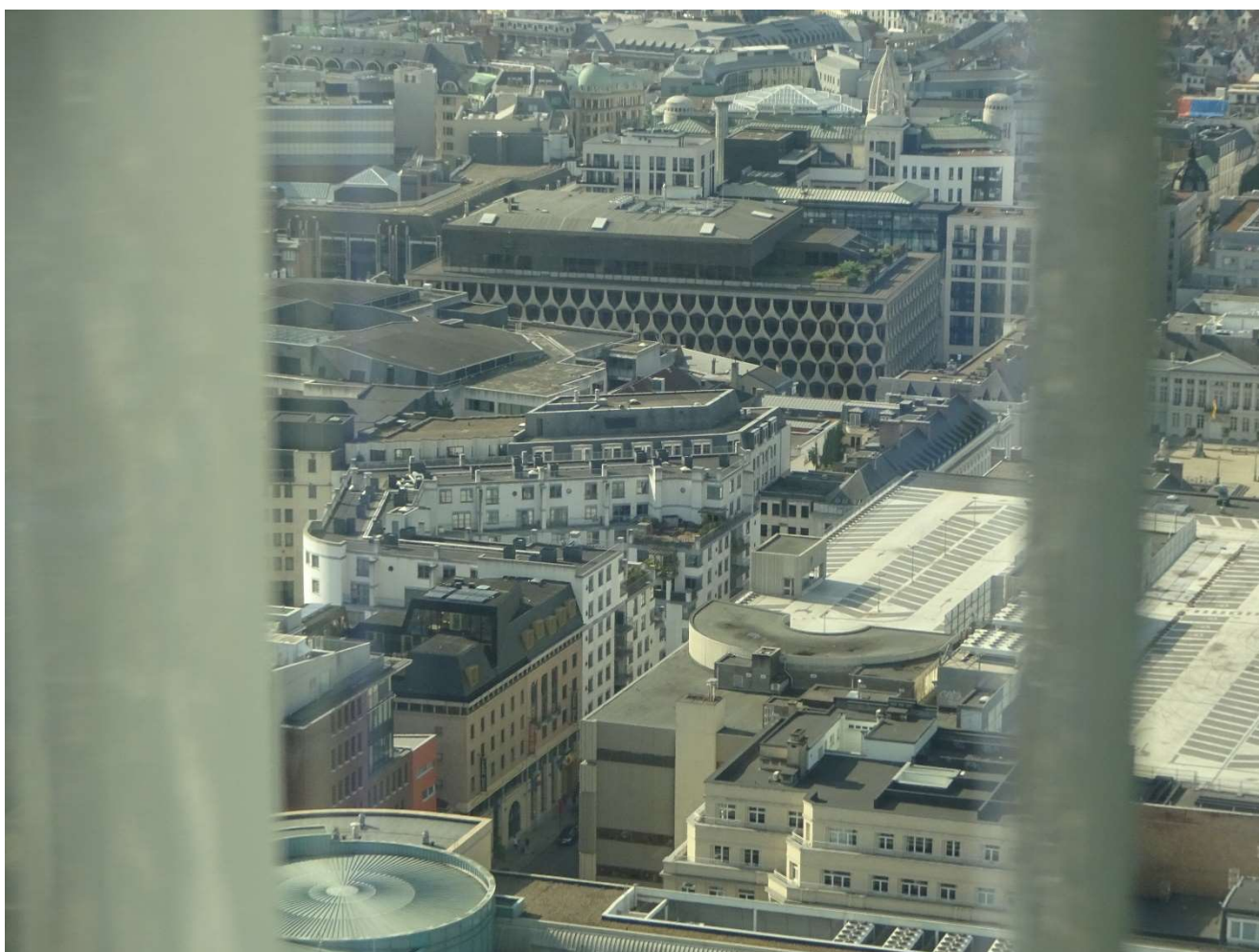
Zicht op het Maraisgebouw langs de kant van de Peterseliestraat vanuit de Dexia-toren (Rogierplein).
